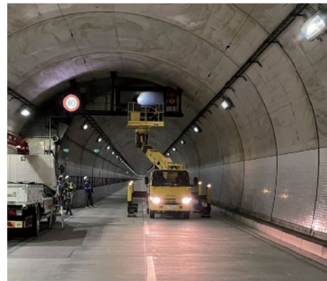
トンネル照明取替
