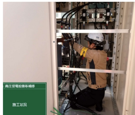
高圧ケーブル端末処理
