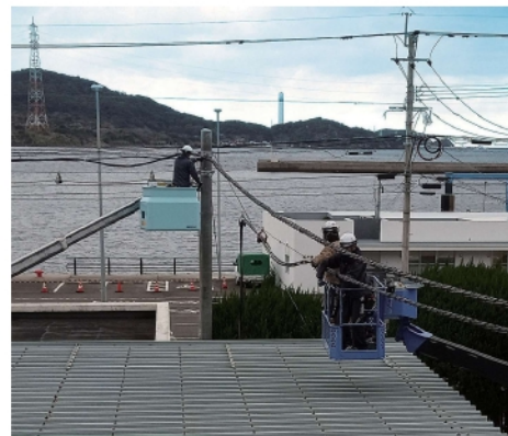
橋内架空線敷設
