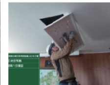
照明器具取付
