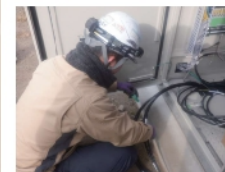
警報ケーブル接続
