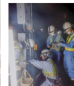
国道信号機点検
