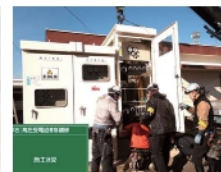
屋外電気室設置
