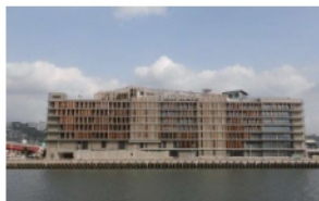
長崎県庁舎行政棟
